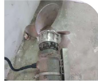
**Agitateur avec dispositif anti-filasse** qui consiste à installer un agitateur avec un dispositif anti-filasse dans les bâches des stations d'assainissement qui permet le déchiquetage des filasses et la mise en suspension des déchets charriés par les effluents sans se colmater et par conséquent faciliter le transfert des effluents par les pompes.
